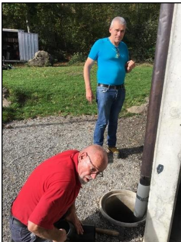
Büffel beim Abfluss reparieren
